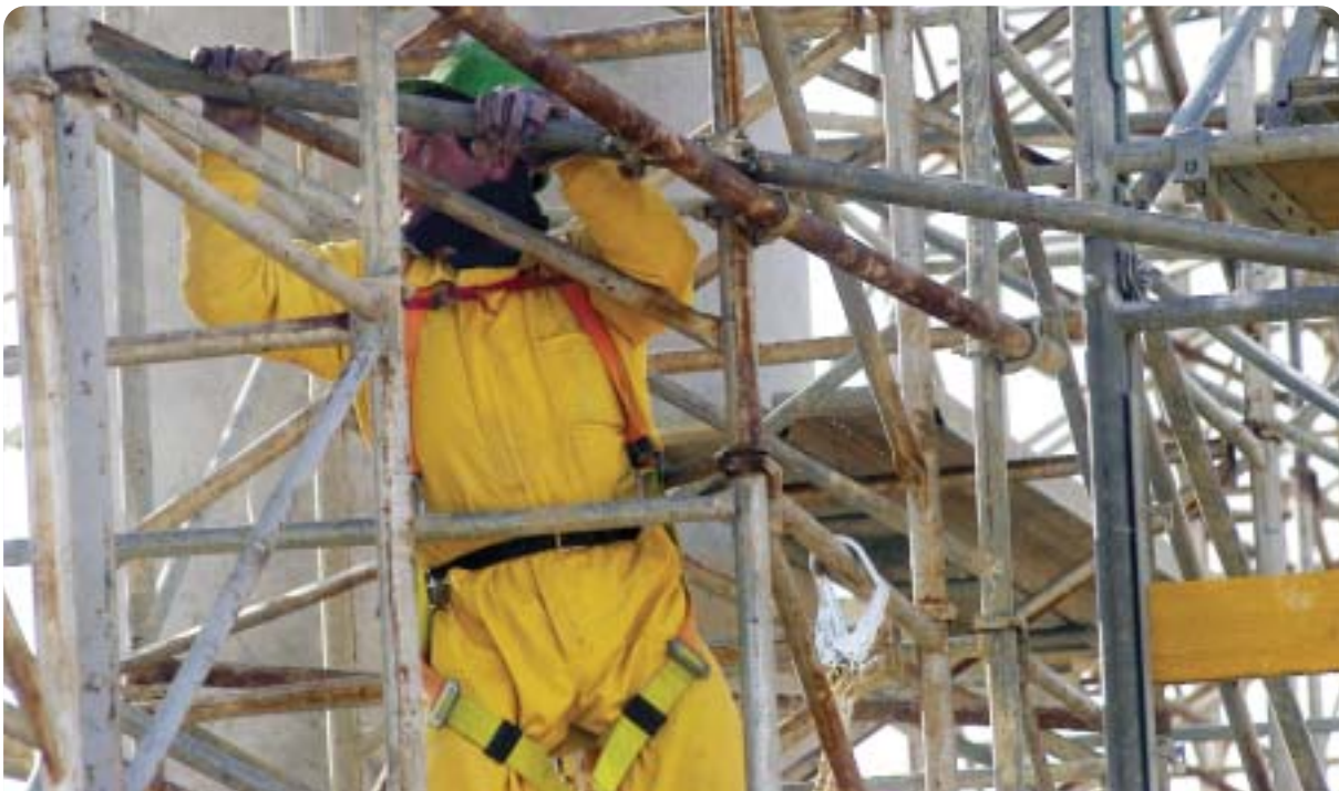
Malaga A-45 Dual Carriageway. Aguilar de la Frontera-Lucena. Andalusia
