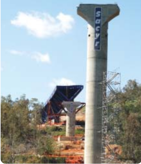
Los Carneros Viaduct. Extremadura
