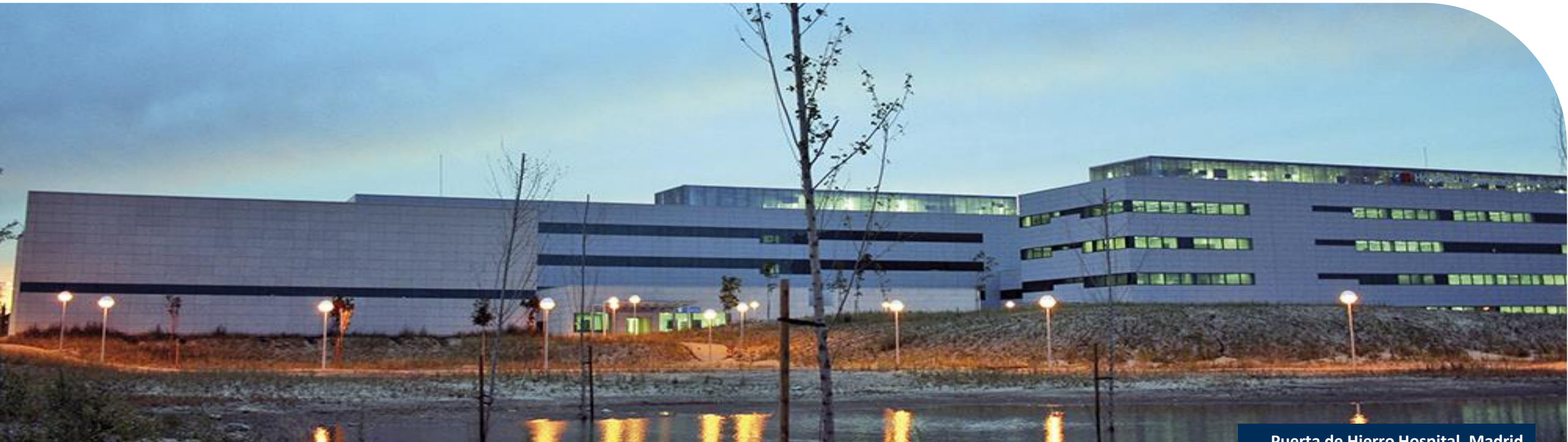
Puerta de Hierro Hospital, Madrid
